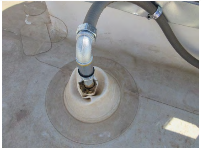
94. Collapsed boot
